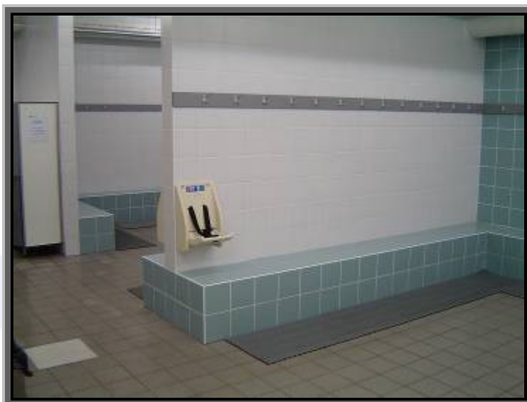
Zona de vestiário dos balneários
