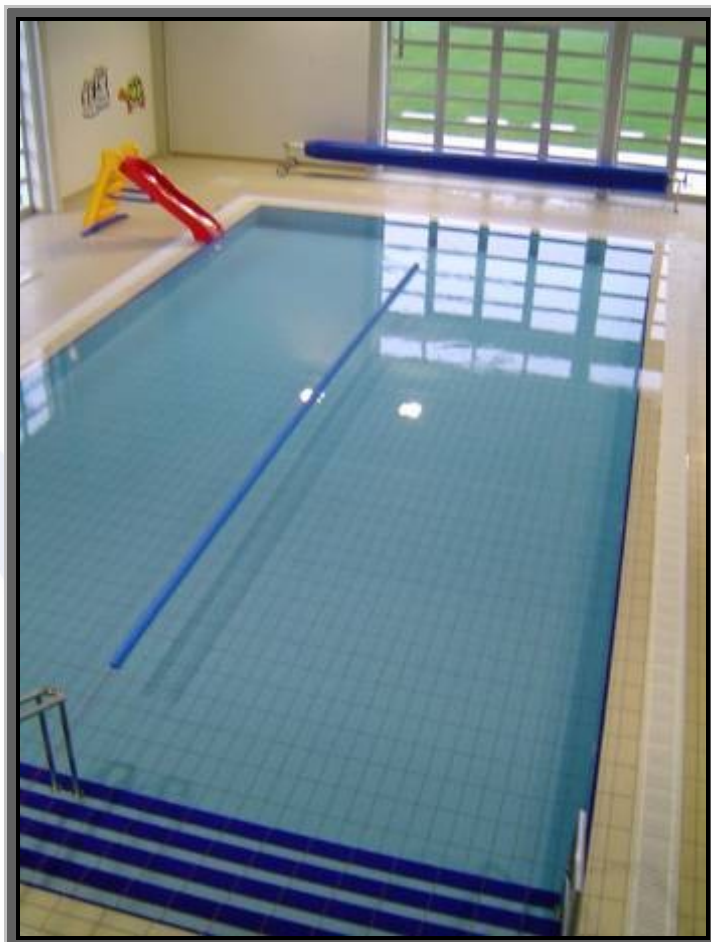
Piscinas de 12,50m X 6,00m com profundidade de 0,60m - 0,90m
