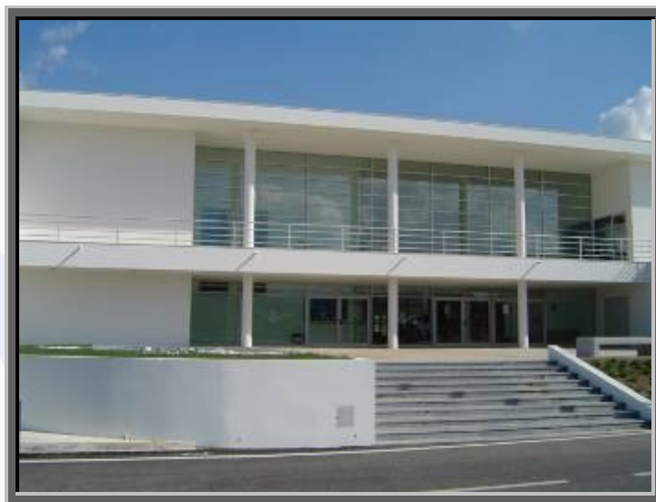
Entrada das Piscinas Municipais de Cantanhede
