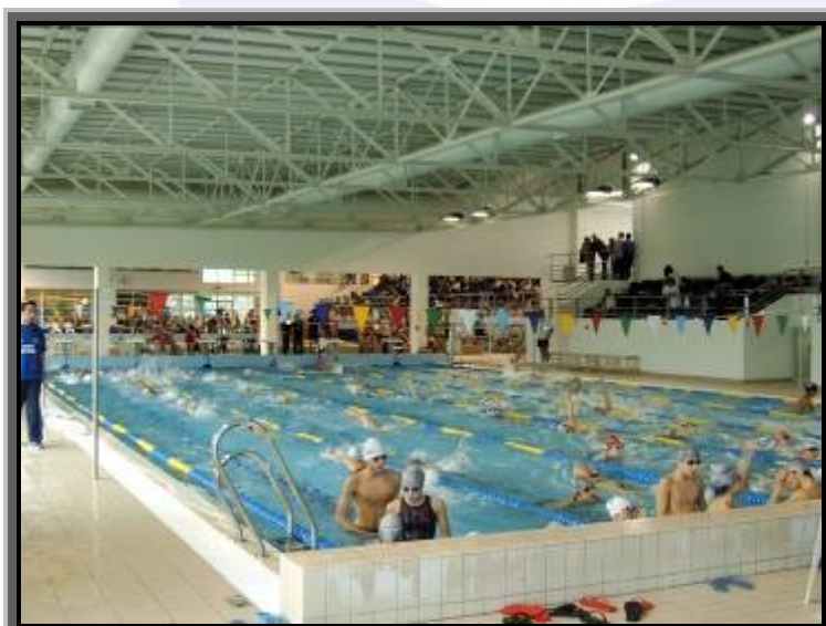
Piscinas de 25,00m X 12,50m com profundidade de 1,00m - 1,50m
